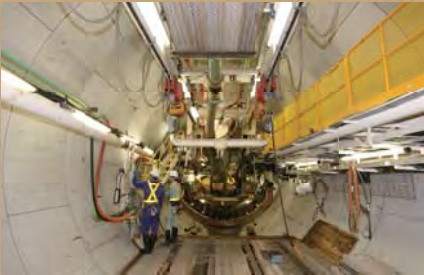
RCセグメントは、シールドマシンが掘削したトンネルの表面を被覆する高機能な構造部品です。耐水性や防火性など必要な機能を加えることも可能です。
