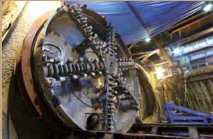
シールドマシンの先端部にあるカッタービットを回転させて、トンネルを掘削していきます。掘削した土砂はマシンの後部に排出されます。
