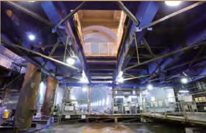
RCセグメントは、立坑部から搬入され、シールドマシンのある坑道先端に移送し組み立てられます。
