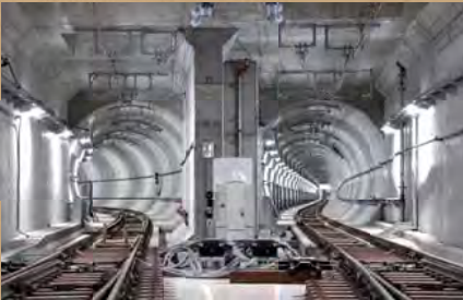
RCセグメントは複雑な線形のトンネルにも対応。曲率に合わせた専用セグメントを設計することで、3次元の曲線トンネルも構築できます。
