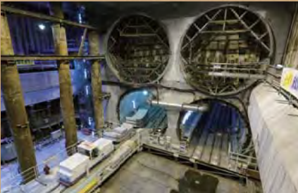
日本のシールド工法は、世界最高水準の技術を持っています。直径15mを超える大口径マシンも稼働し、大空間の地下施設の建設に利用されています。
